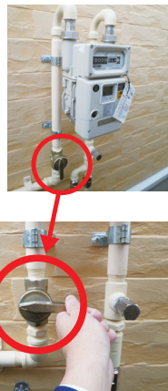
▲メーターガス栓閉止
